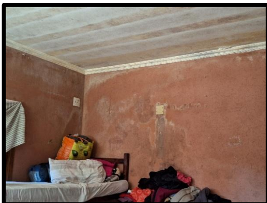
Figuras 11 e 12 – Infiltração na parede do quarto coletivo.
