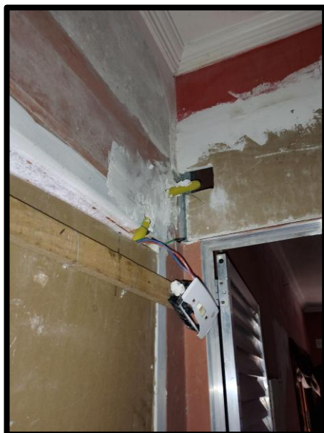
Figuras 19, 20, 21 e 22 - Fiações expostas no andar inferior, onde foi constatado diversos focos de infiltração.
