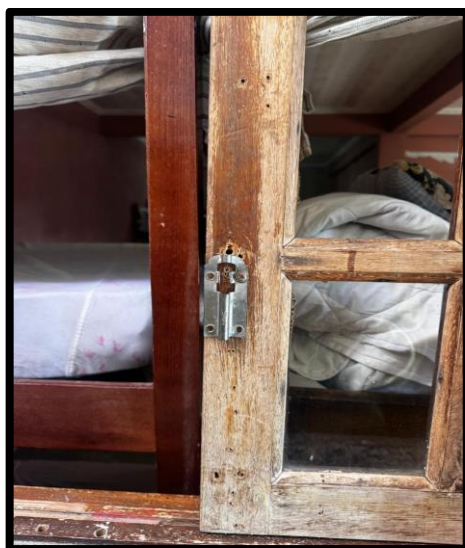
Figuras 40 e 41 – Janelas com trinco externo.
