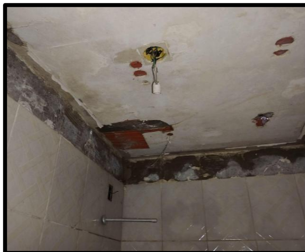
Figuras 19, 20, 21 e 22 - Fiações expostas no andar inferior, onde foi constatado diversos focos de infiltração.
